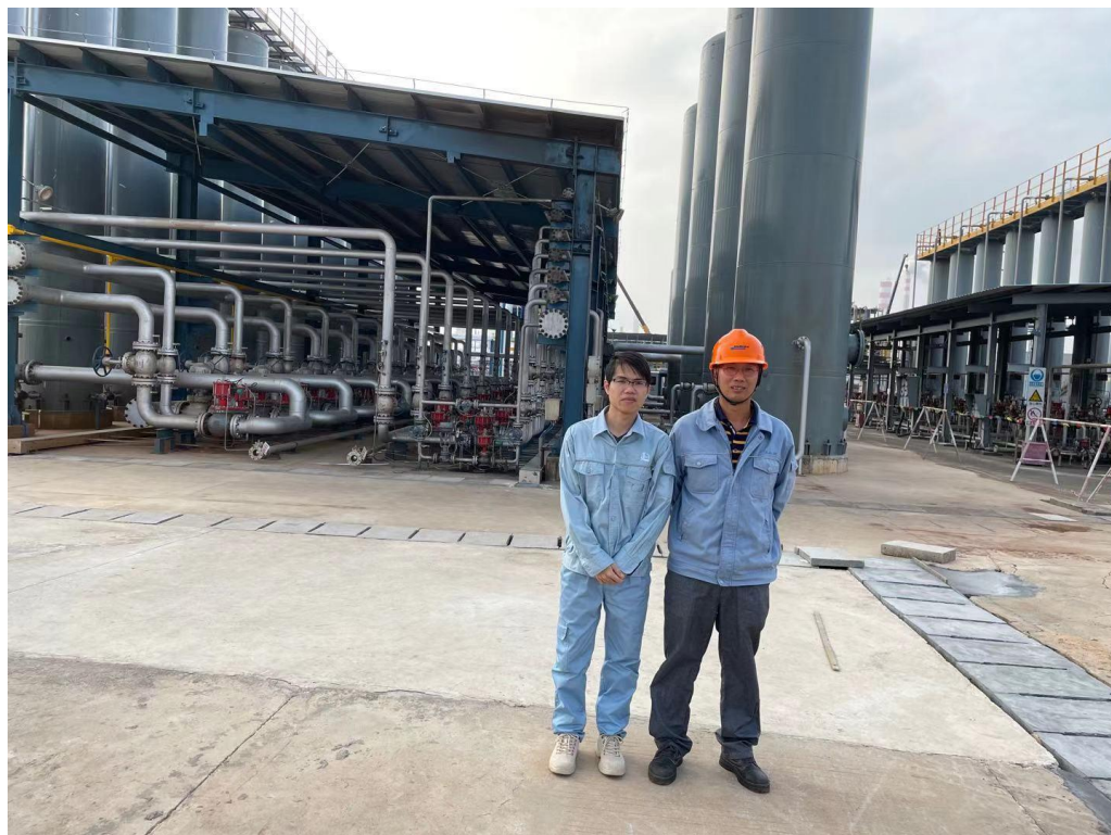
现场勘察影像：
