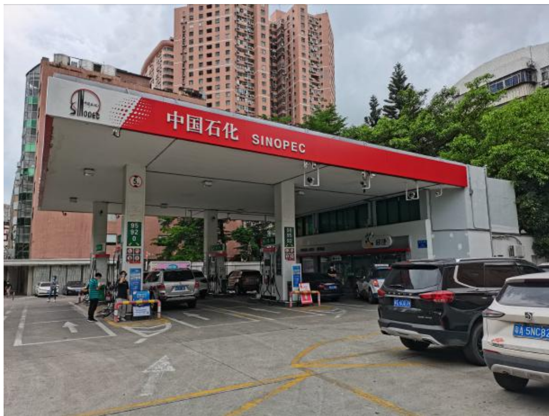
广东深圳翠竹加油站现场勘察影像：
