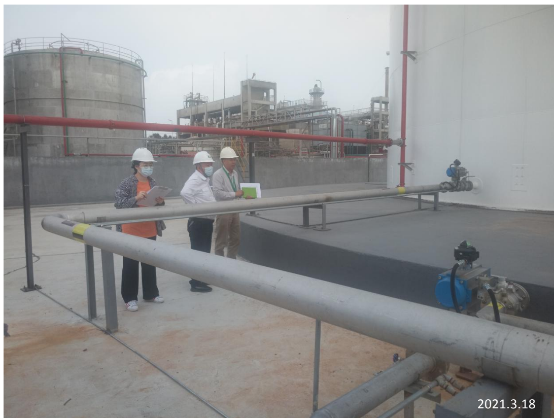
建滔（番禺）化工有限公司现场勘察影像：
