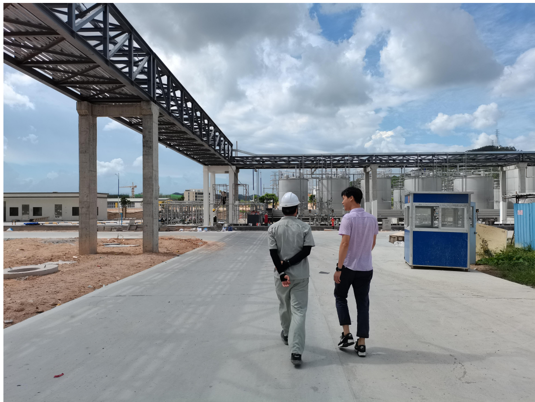
现场勘察影像：
