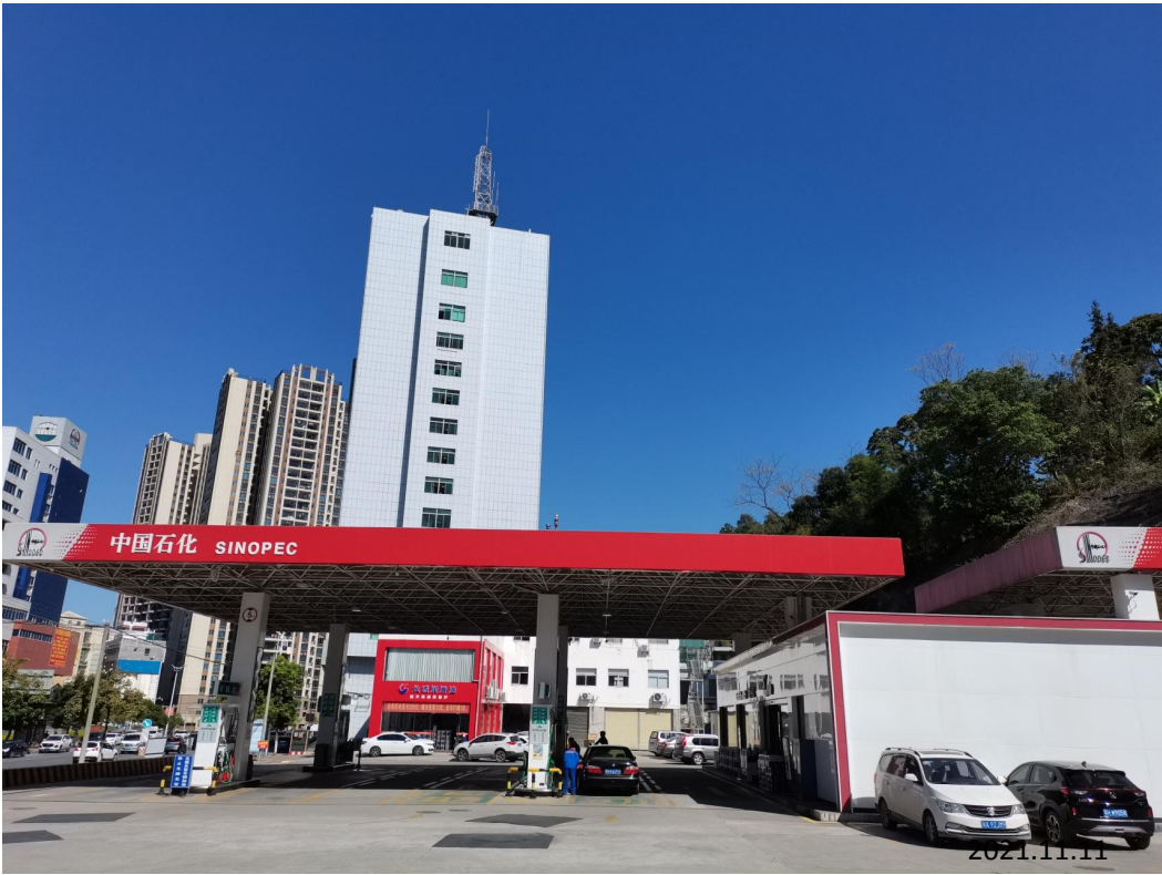
中国石化销售股份有限公司广东肇庆广宁宁城加油站现场勘察影像：
