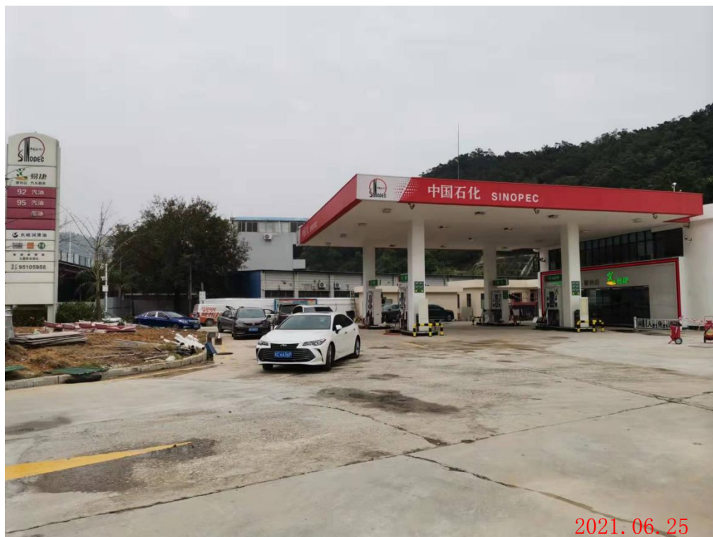
深圳沙鱼涌加油站现场勘察影像：
