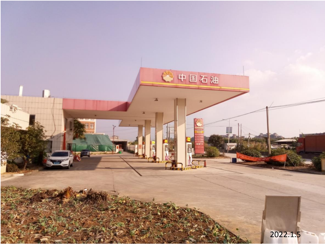
中国石油天然气股份有限公司广东云浮新兴水台加油站现场勘察影像：
