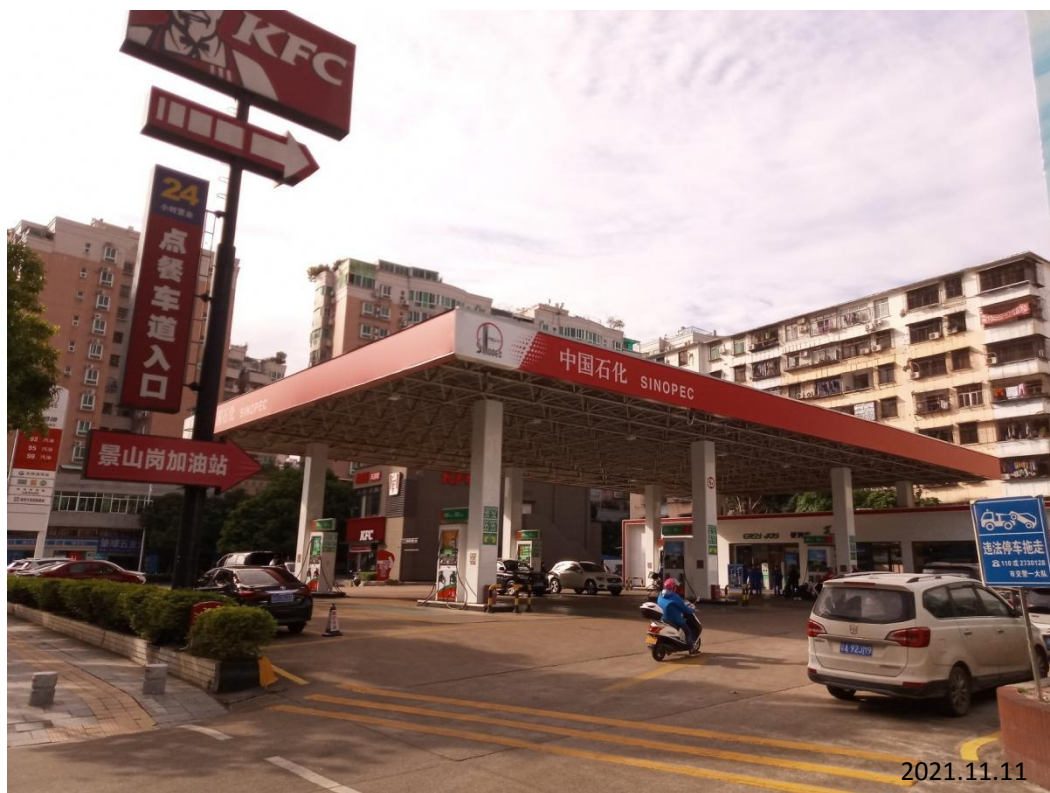
景山岗加油站现场勘察影像：
