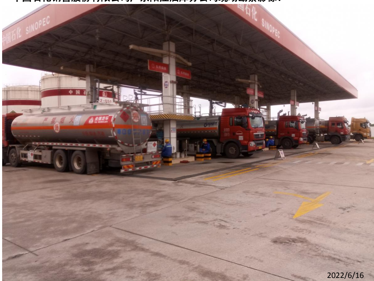
中国石化销售股份有限公司广东阳江油库分公司现场勘察影像：
