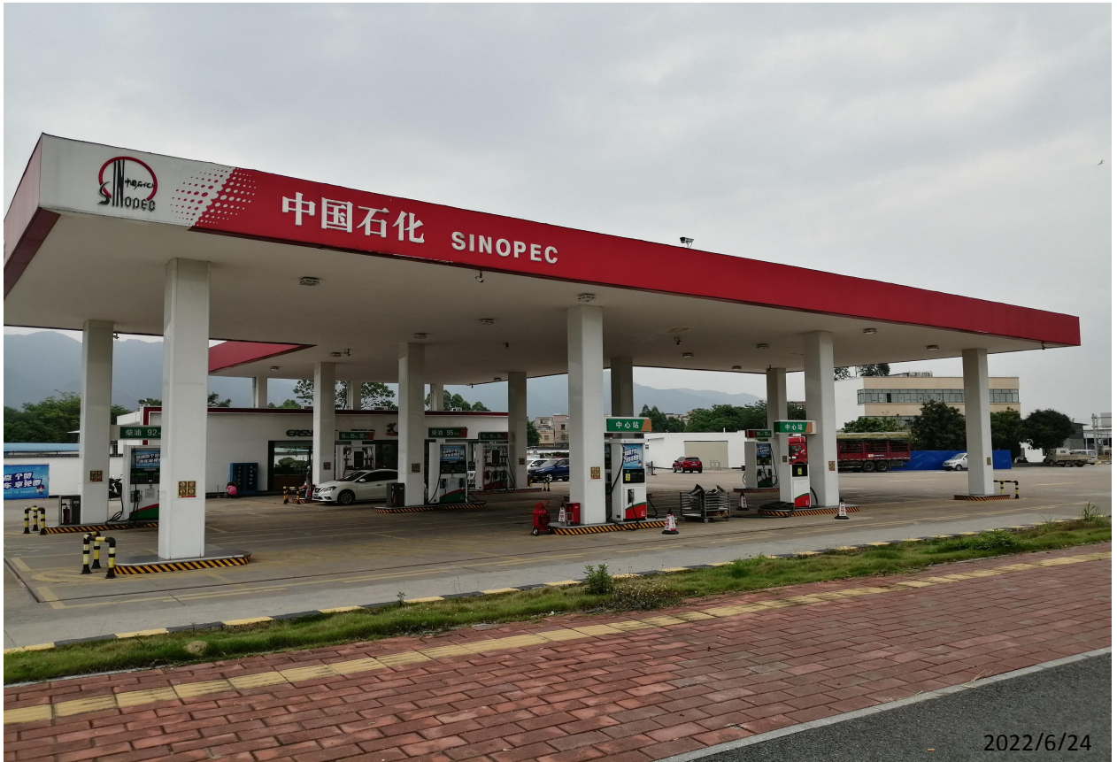
中国石化销售股份有限公司广东肇庆高要利星东加油站现场勘察影像：
