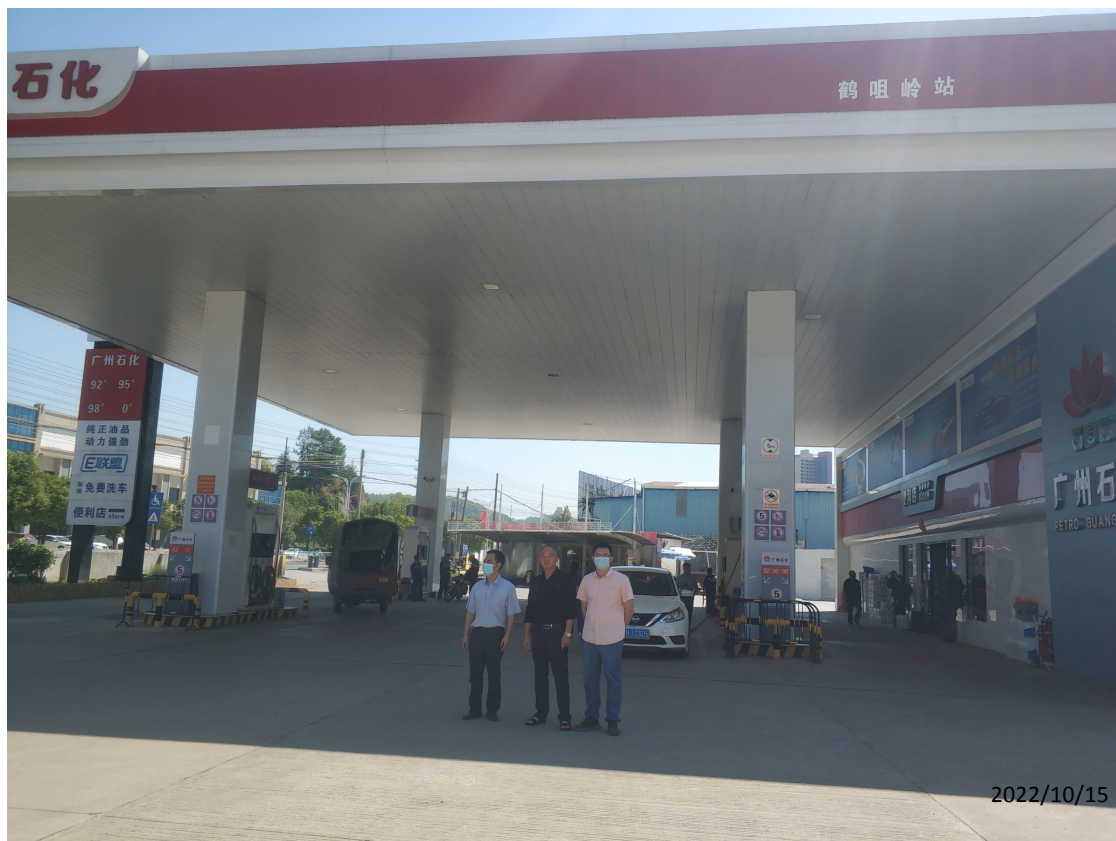
怀集县怀城镇鹤咀岭加油站现场勘察影像：
