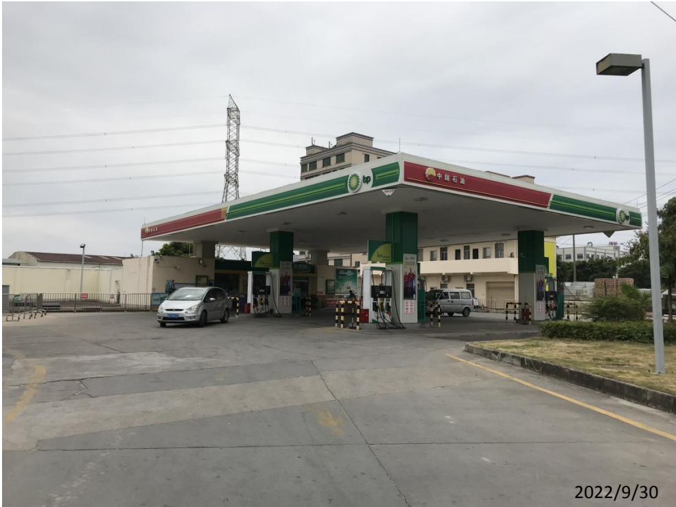
东莞市石排向西加油站有限公司现场勘察影像：
