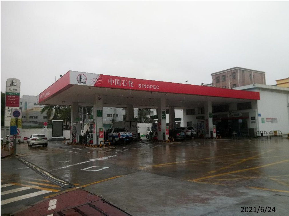
中国石化销售股份有限公司广东深圳坑梓加油站现场勘察影像：
