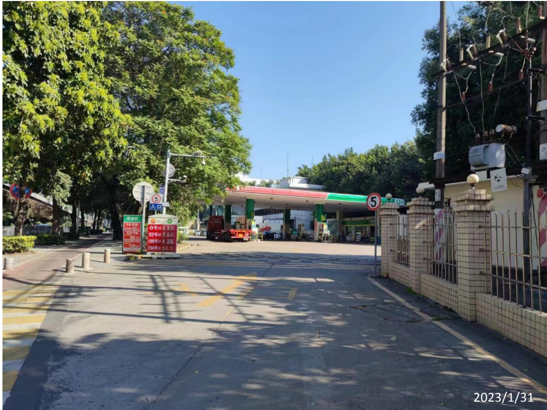
中油碧辟石油有限公司东莞联丰加油站现场勘察照片：
