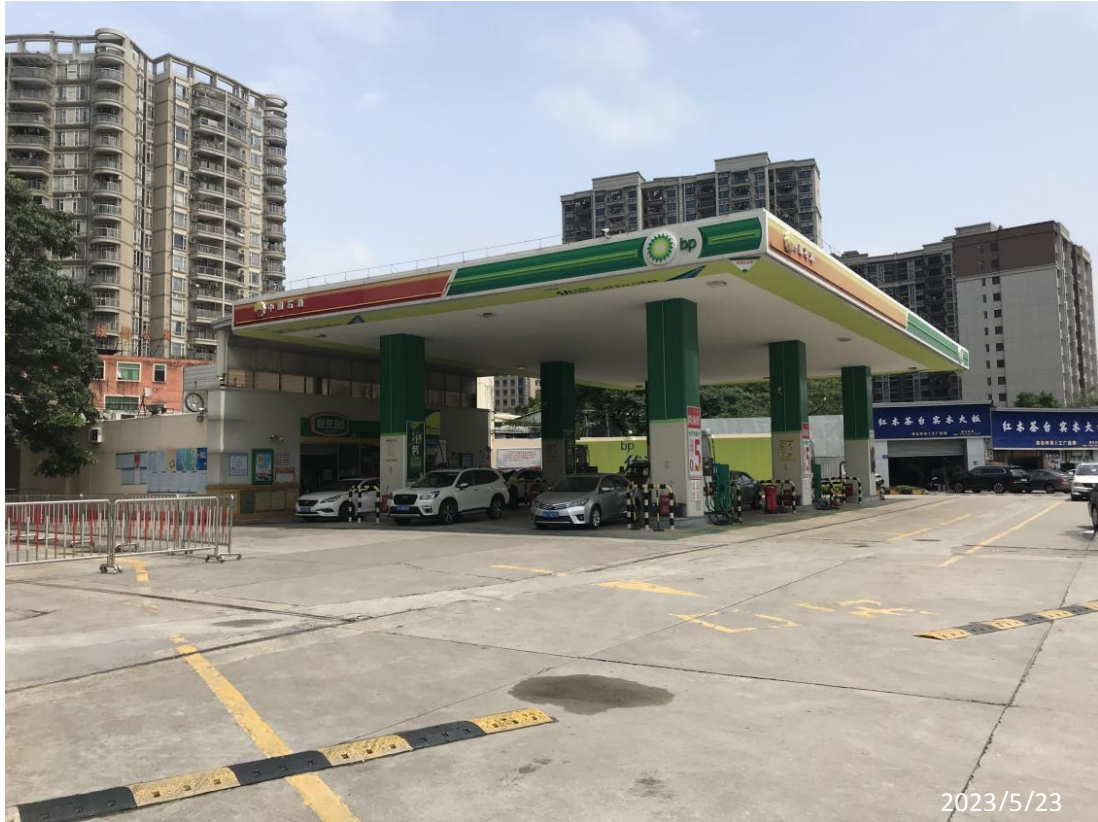
东莞市厚街丰兴加油站（普通合伙）现场勘察照片：
