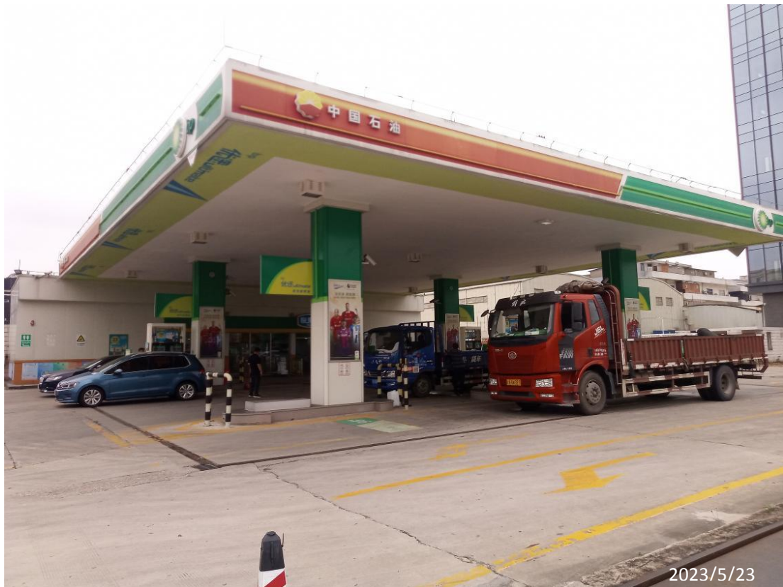
东莞市盈顺实业有限公司顺达加油站现场勘察照片：
