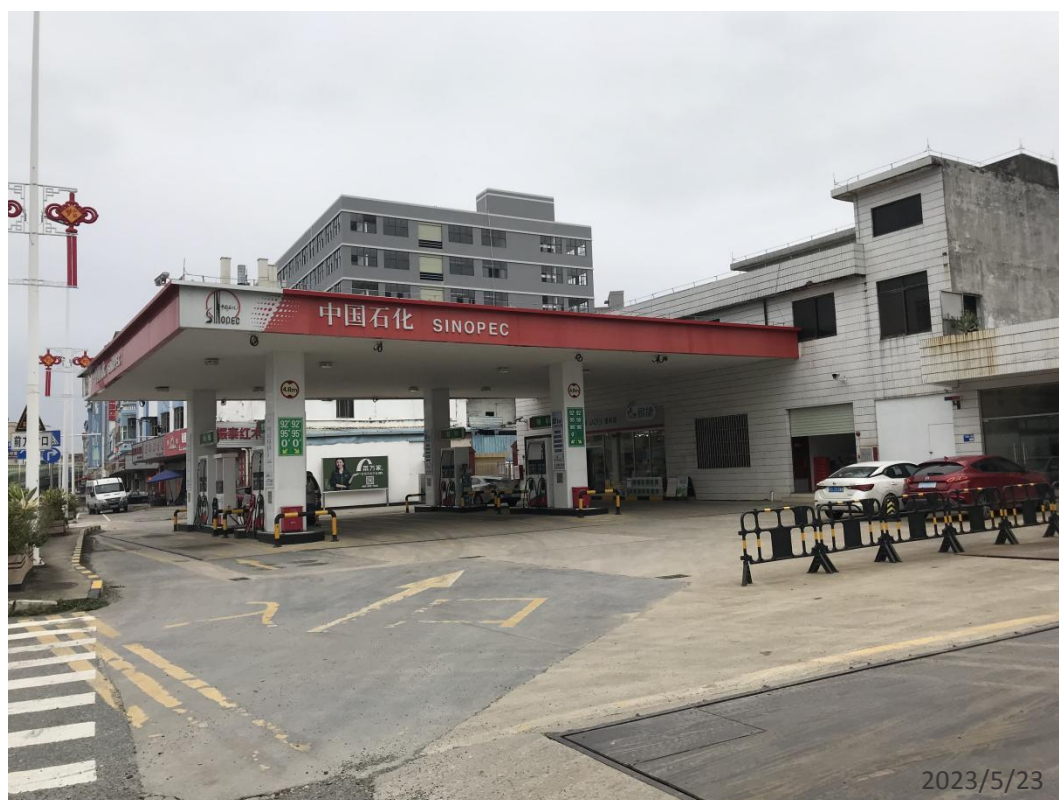
中国石化销售股份有限公司广东东莞茶山茶溪加油站现场勘察照片：
