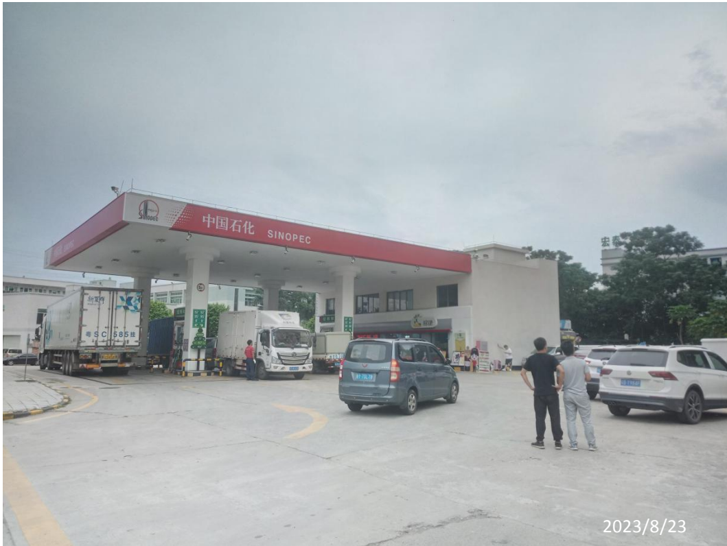
中国石化销售股份有限公司广东东莞横沥山厦加油站现场勘察照片：
