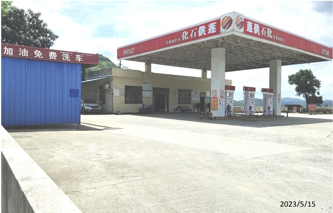
桂阳县莲塘镇莲供加油站现场勘察影像：
