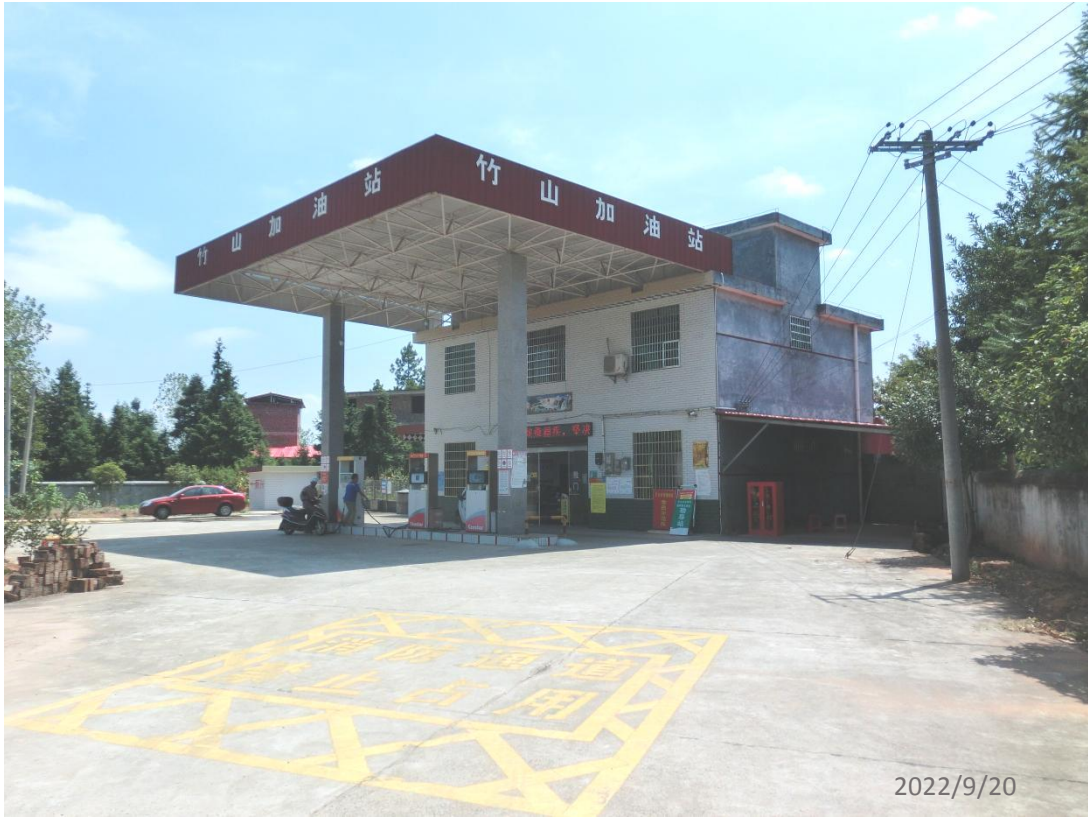
安仁竹山加油站现场勘察影像：
