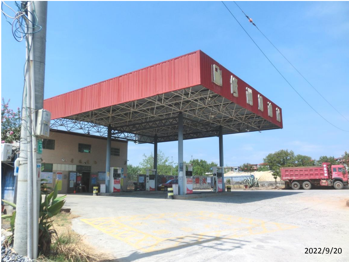
安仁县承坪低洲加油站现场勘察影像：
