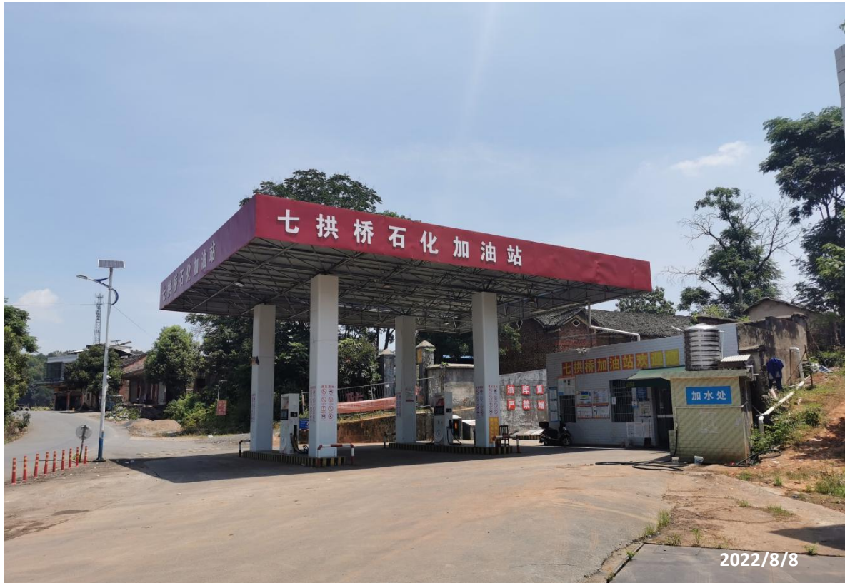
桂阳县敖泉镇七拱桥加油站现场勘察影像：
