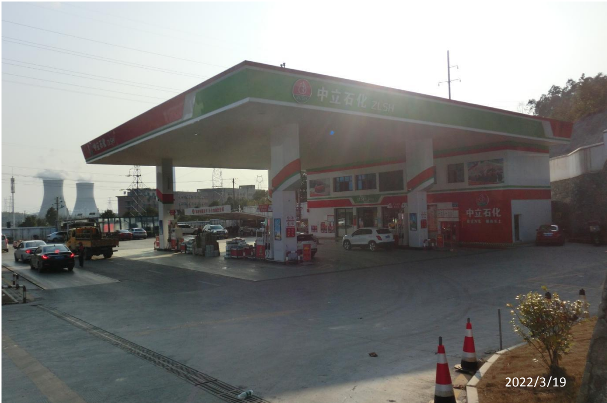
郴州市杰意石油化工有限责任公司资兴市阳安加油站现场勘察影像：
