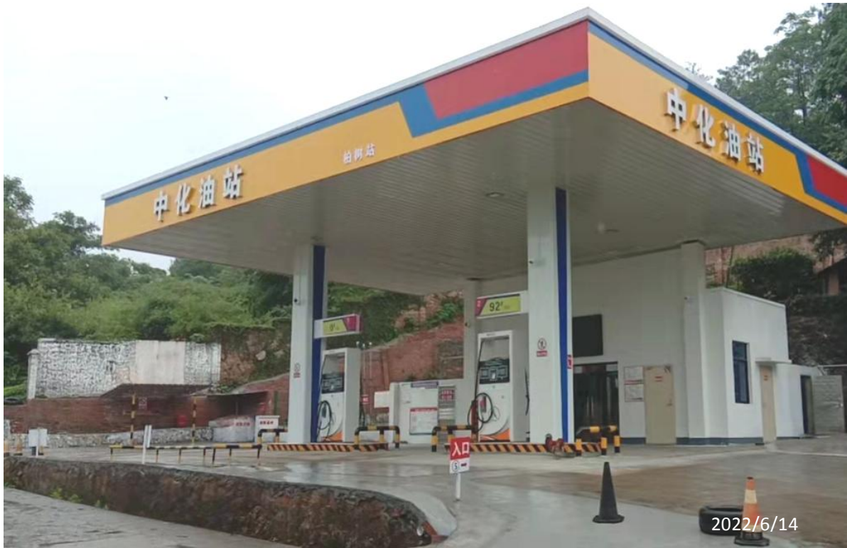
七里柏树加油站现场勘察影像：
