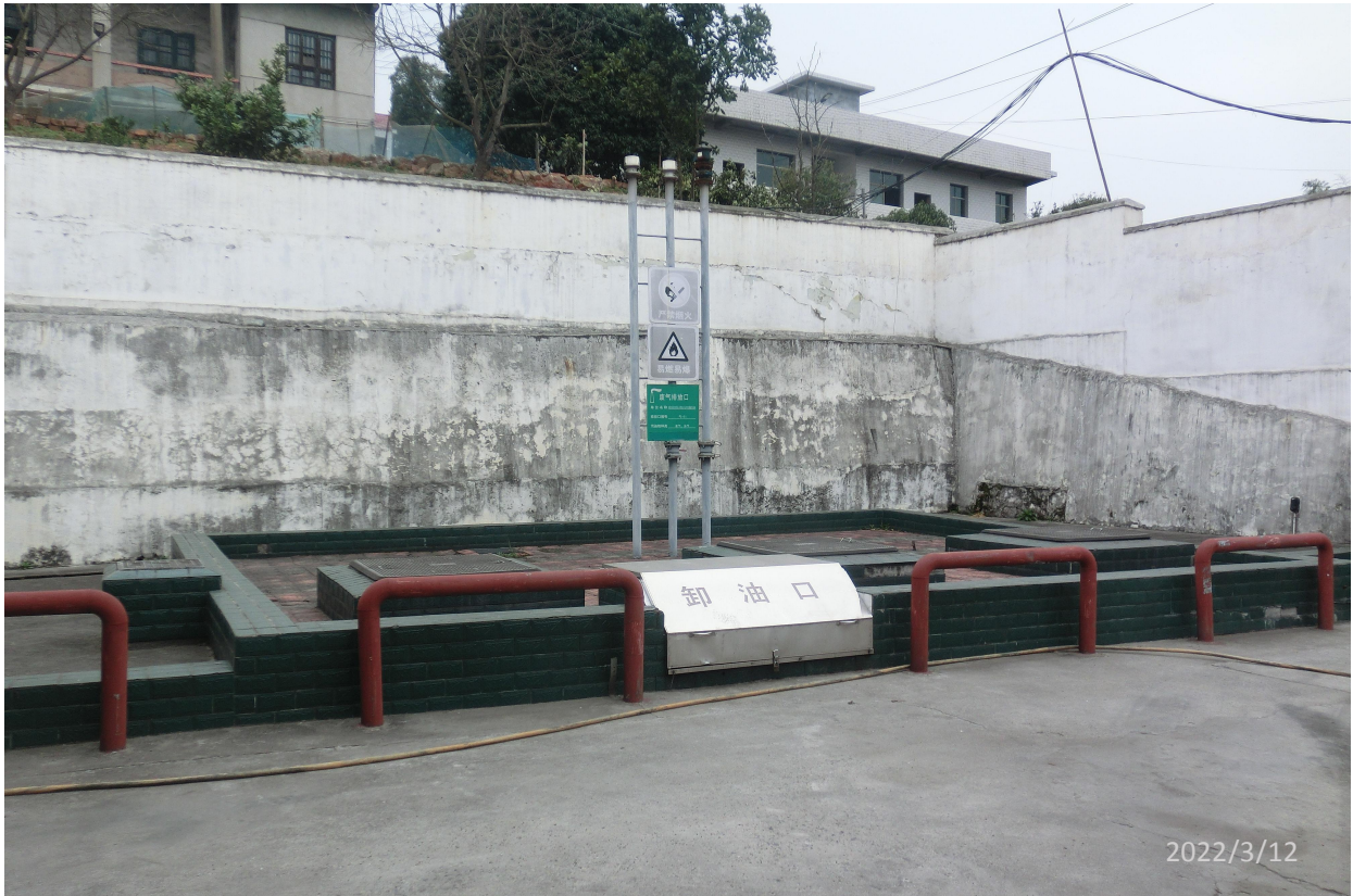
中石化郴州公司花园墟加油站改造项目现场勘察影像：
