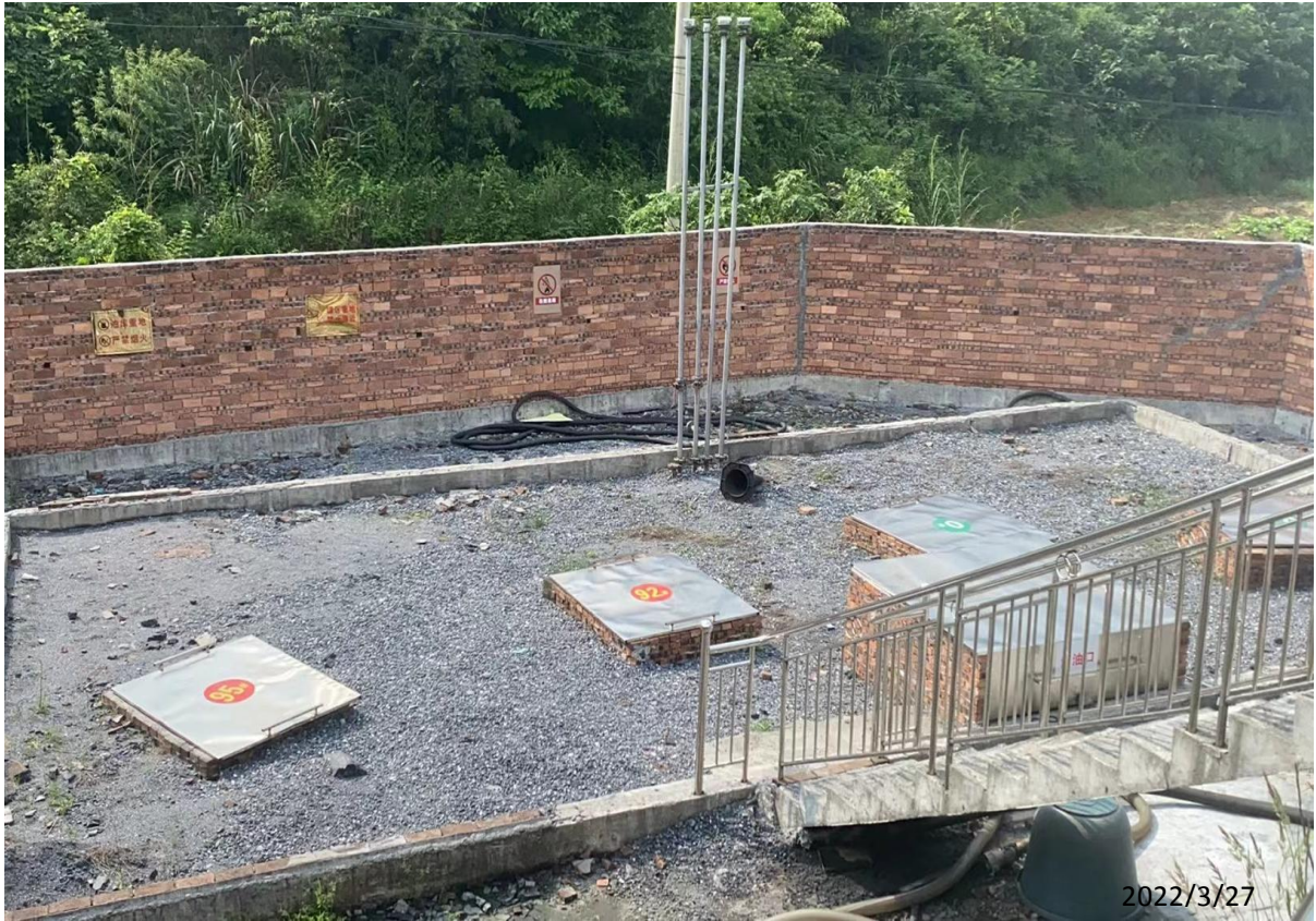
湖南天晟石油化工有限公司郴州市北湖区兴宇加油站现场勘察影像：
