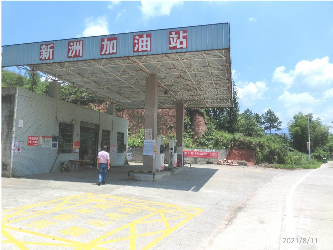
安仁县新洲加油站现场勘察影像：
