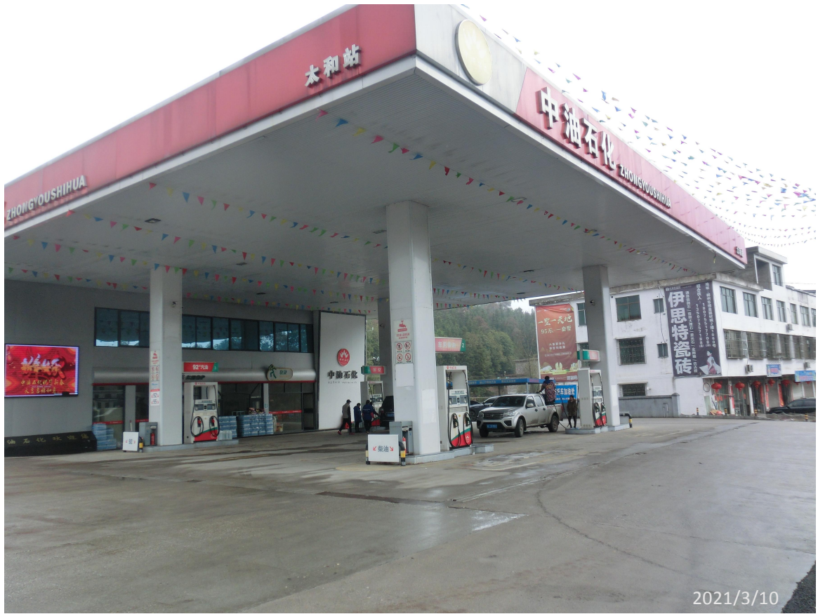
永兴县太和乌萝燃料有限公司太和乌萝加油站现场勘察影像：
