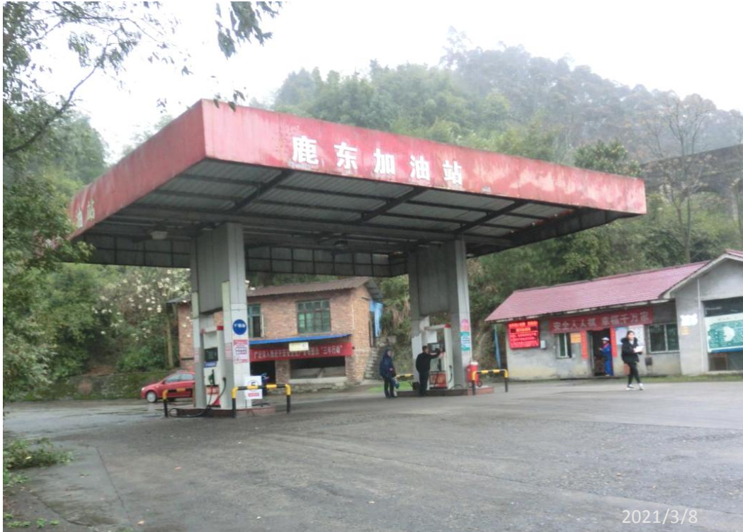
资兴市石油实业有限公司三都鹿东加油站现场勘察影像：
