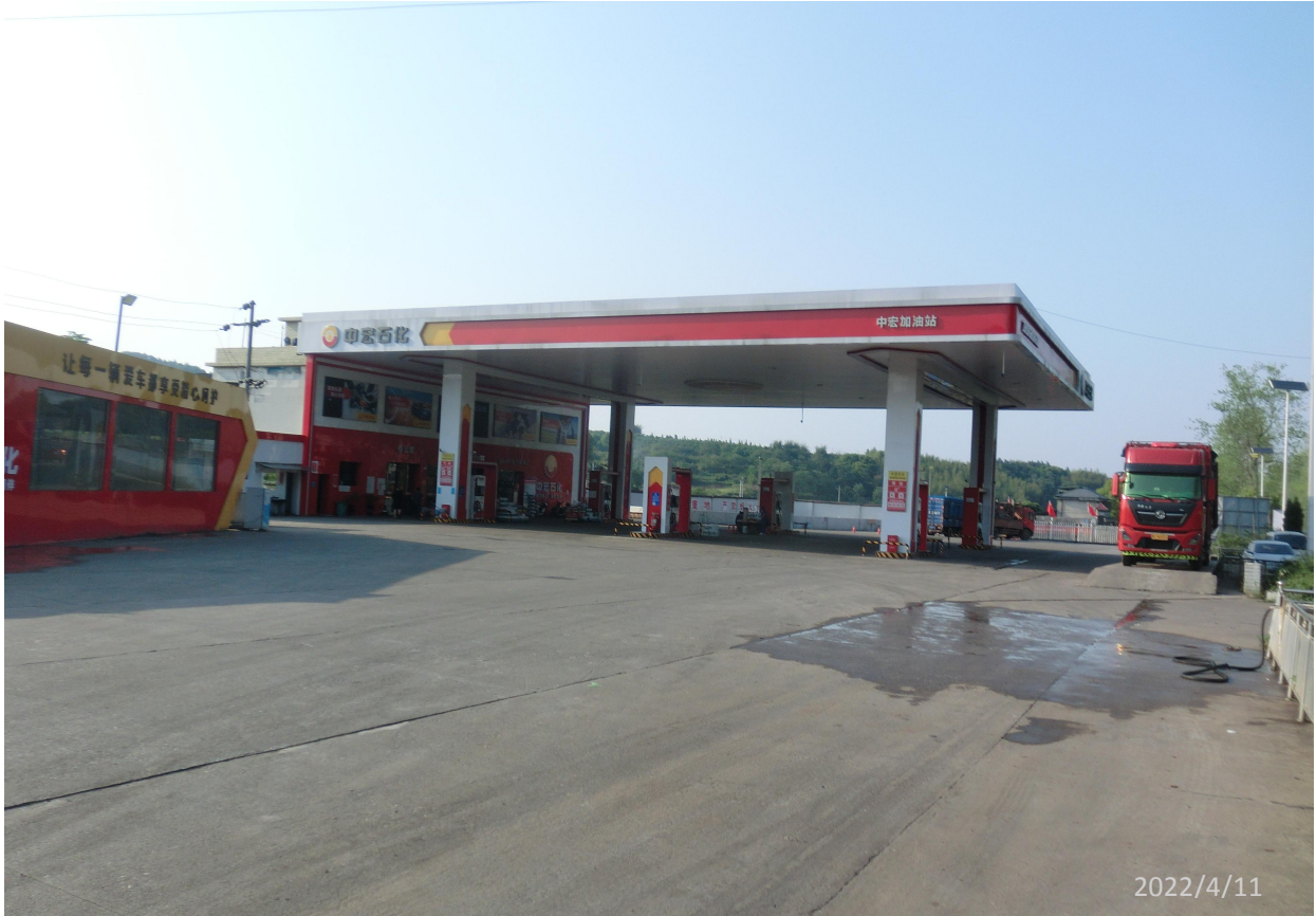
郴州市中宏加油站现场勘察影像：
