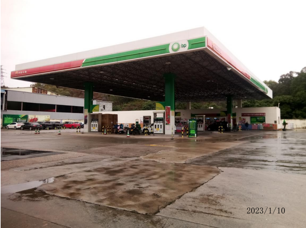
中油碧辟石油有限公司河源风光加油站现场勘察影像：
