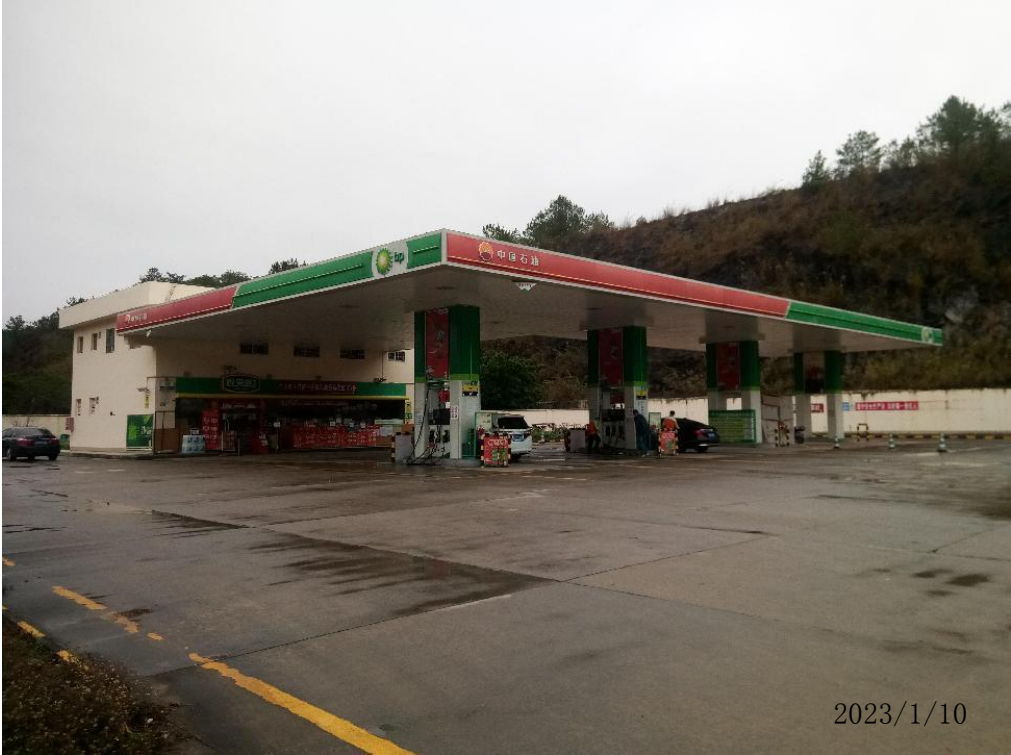
中油碧辟石油有限公司河源市江东三号加油站现场勘察影像：
