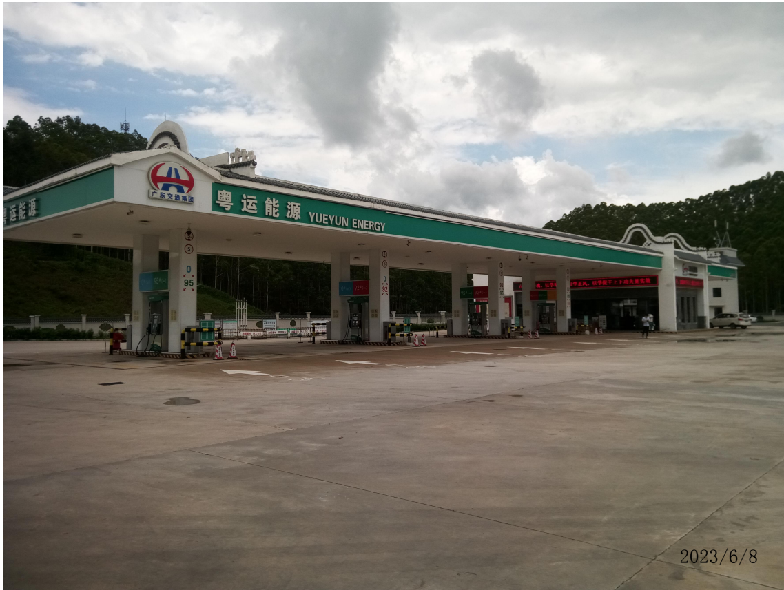
广东通驿高速公路服务区有限公司佛冈江坳服务区南区加油站现场勘察影像：
