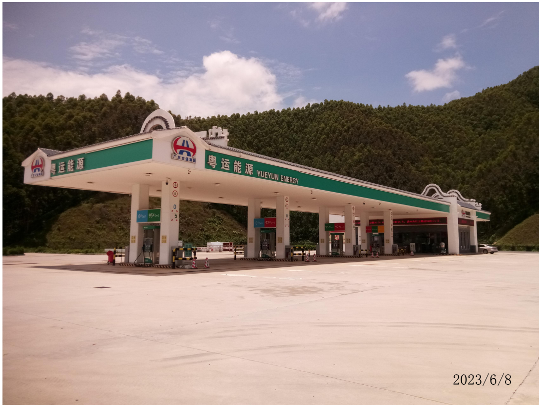
广东通驿高速公路服务区有限公司佛冈江坳服务区北区加油站现场勘察影像：
