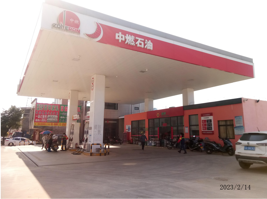
紫金县上义兵兵加油站有限公司现场勘察影像：
