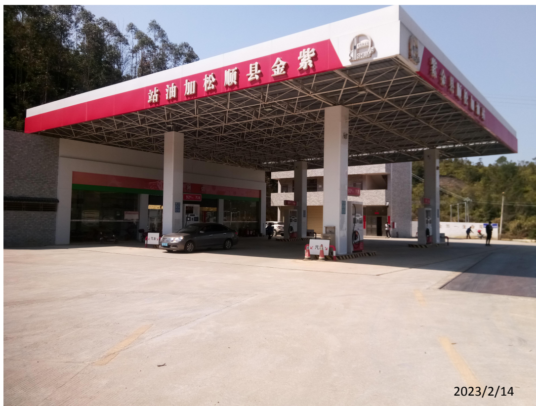
紫金县水墩顺松加油站有限公司现场勘察影像：
