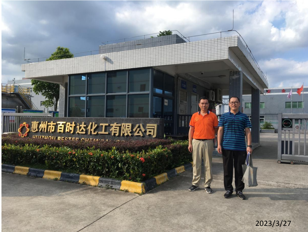
惠州市百时达化工有限公司现场勘察照片：
