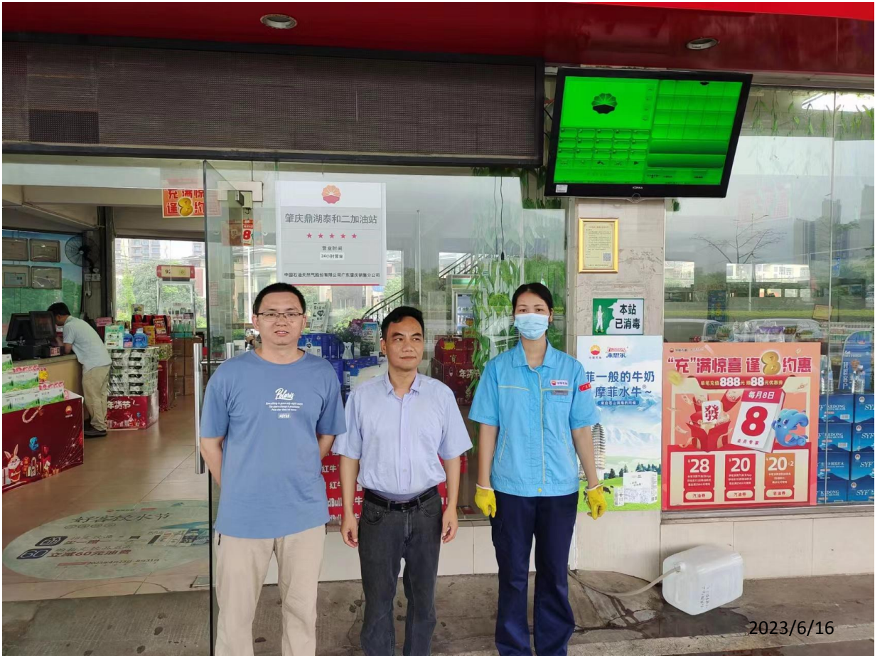
肇庆市高要区中油油站经营有限公司鼎湖泰和二加油站现场勘察影像：
