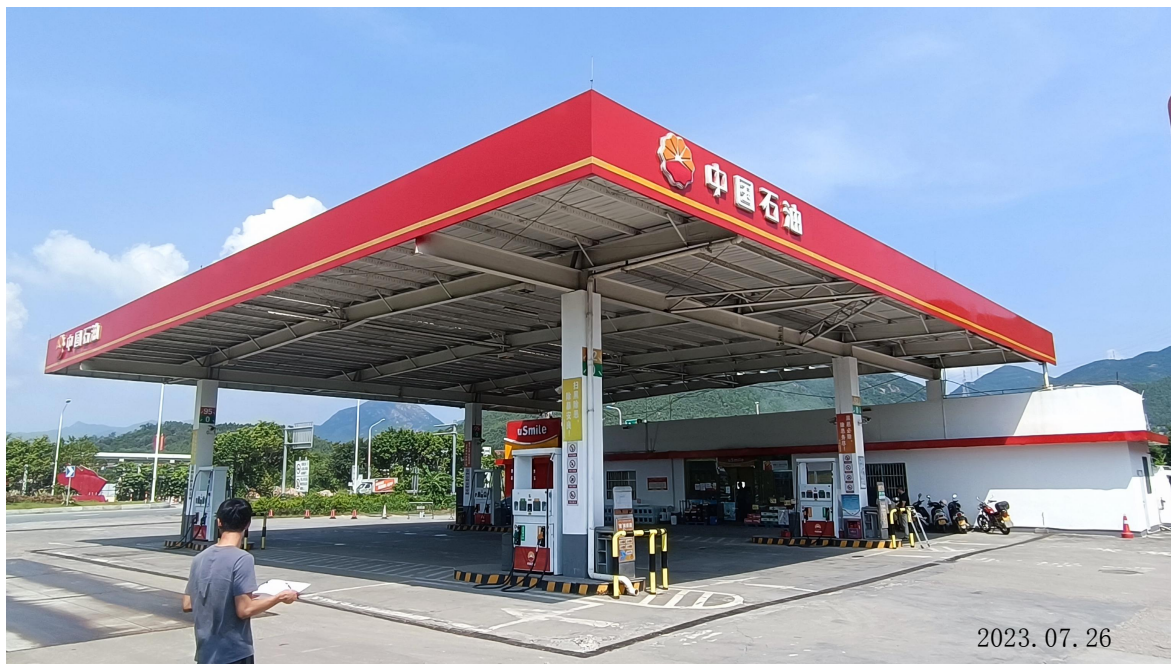
中国石油天然气股份有限公司广东江门新会崖门加油站现场勘察影像：
