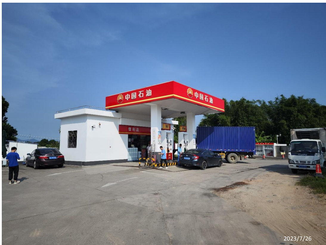
中国石油天然气股份有限公司广东新会双水嘉寮德荣加油站现场勘察照片：
