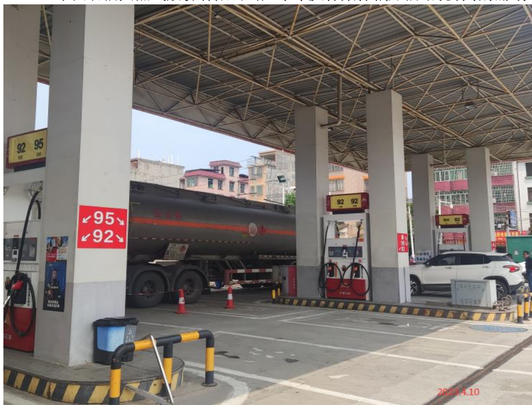
中国石油天然气股份有限公司广东肇庆怀集怀城加油站现场勘察影像:
