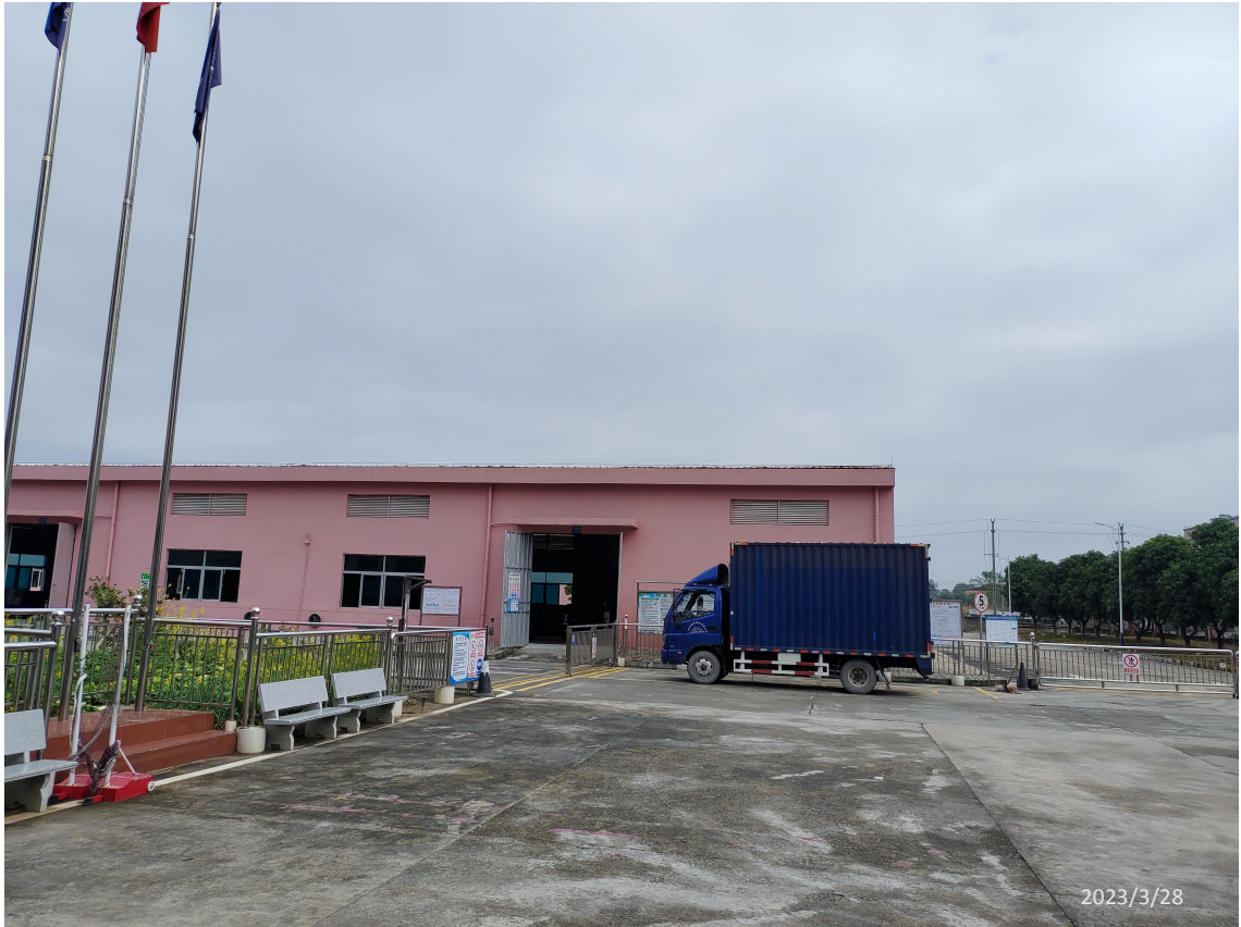
惠州兴鑫涂料化工有限公司现场勘察照片：
