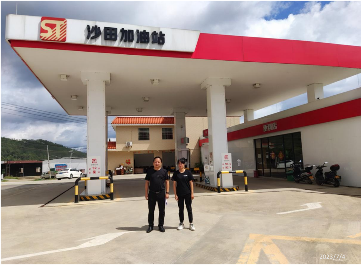
新丰县沙田加油站现场勘察影像：
