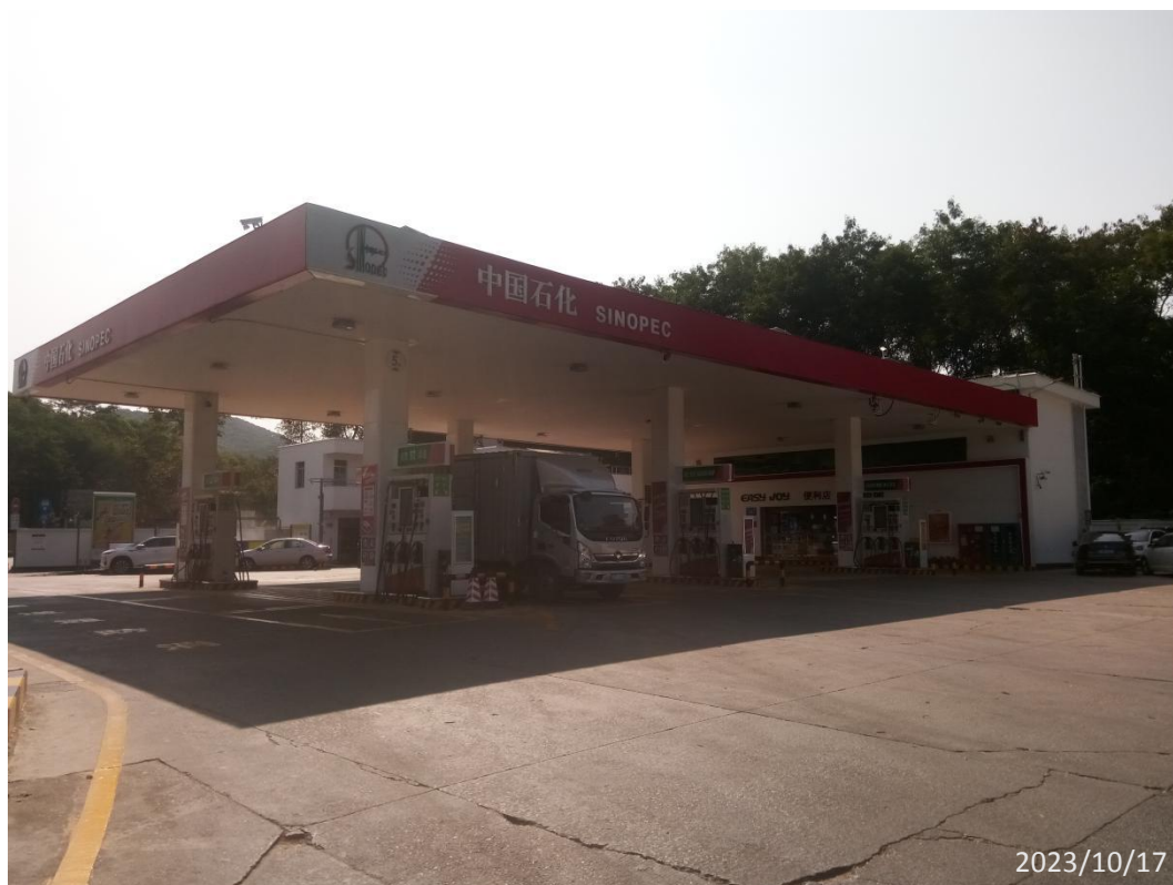
中国石化销售股份有限公司广东深圳宝华加油站现场勘察照片：
