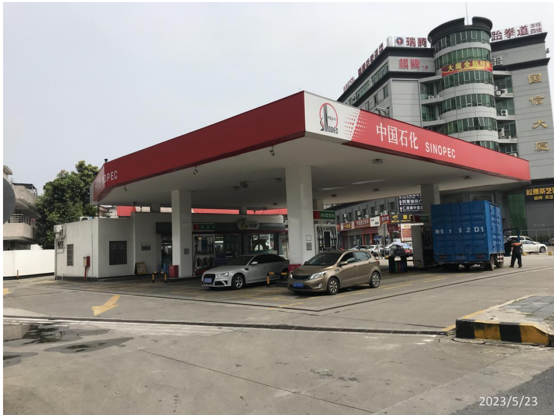
中国石化销售股份有限公司广东东莞南城胜和加油站现场照片：
