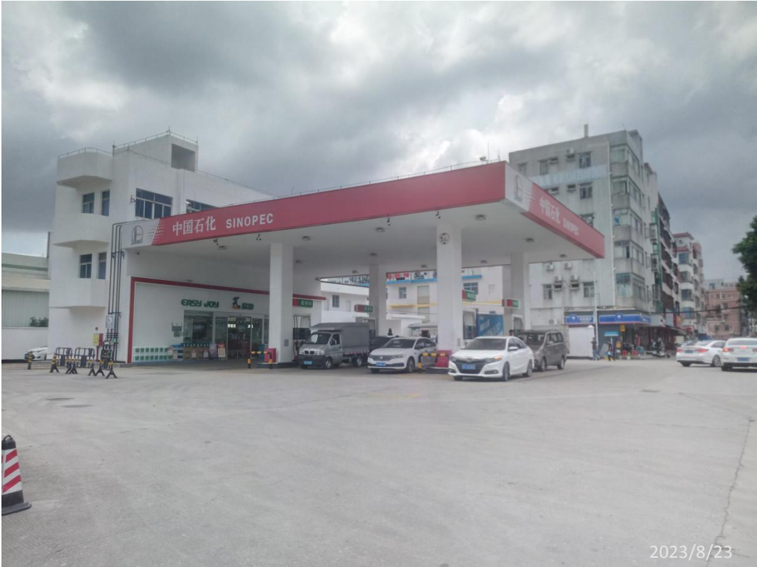
中国石化销售股份有限公司广东东莞塘厦清湖头加油站现场照片：
