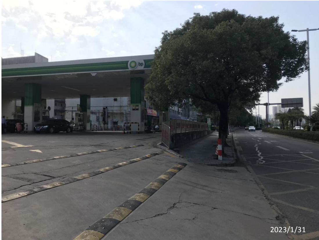
中油碧辟石油有限公司东莞振兴加油站现场照片
