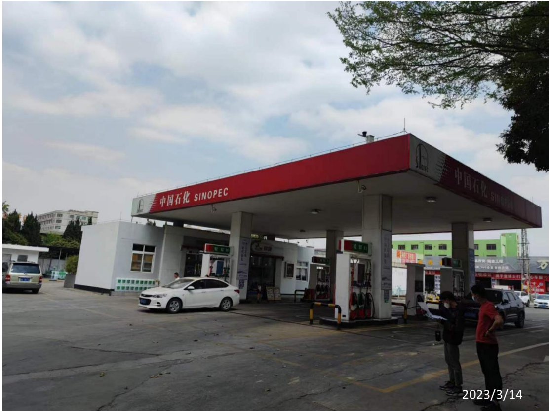
中国石化销售股份有限公司广东东莞大朗南方加油站现场照片
