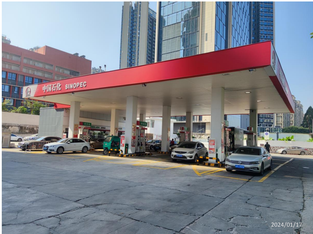
中国石化销售股份有限公司广东深圳铿润加油站现场照片：
