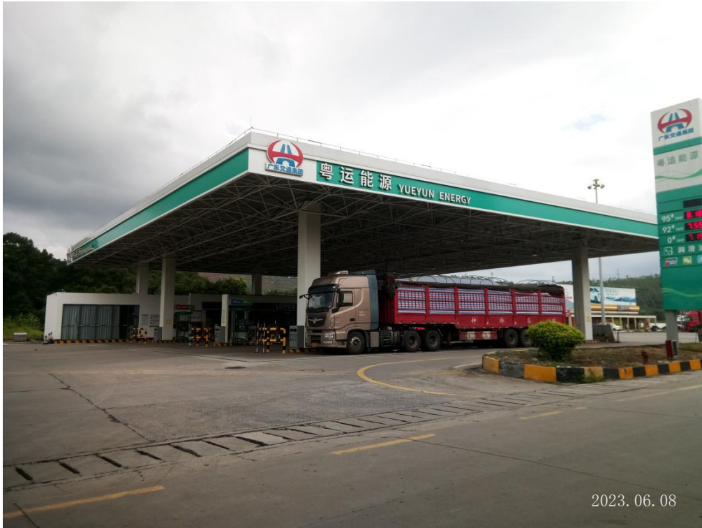
广东通驿高速公路服务区有限公司曲江服务区东区加油站现场勘察影像：
